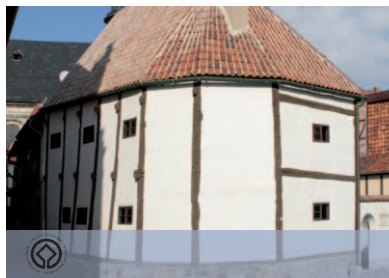
Das älteste Fachwerkhhaus in Quedlinburg – ein Ständerbau | The oldest timber framed house in Quedlinburg
