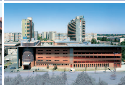
Magistrale Carré mit Blick auf Halle-Neustadt | Magistrale Carré overlooking Halle-Neustadt
