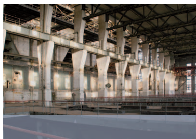
Das ehemalige Kraftwerk Vockerode wird heute kulturell genutzt | The former power station in Vockerode is today used for cultural events
